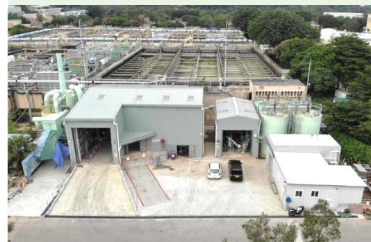
「廚餘、污泥共厭氧消化」 設施 (沙田污水處理廠)
