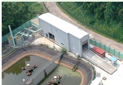
「廚餘、污泥共厭氧消化」 設施 (大埔污水處理廠)
